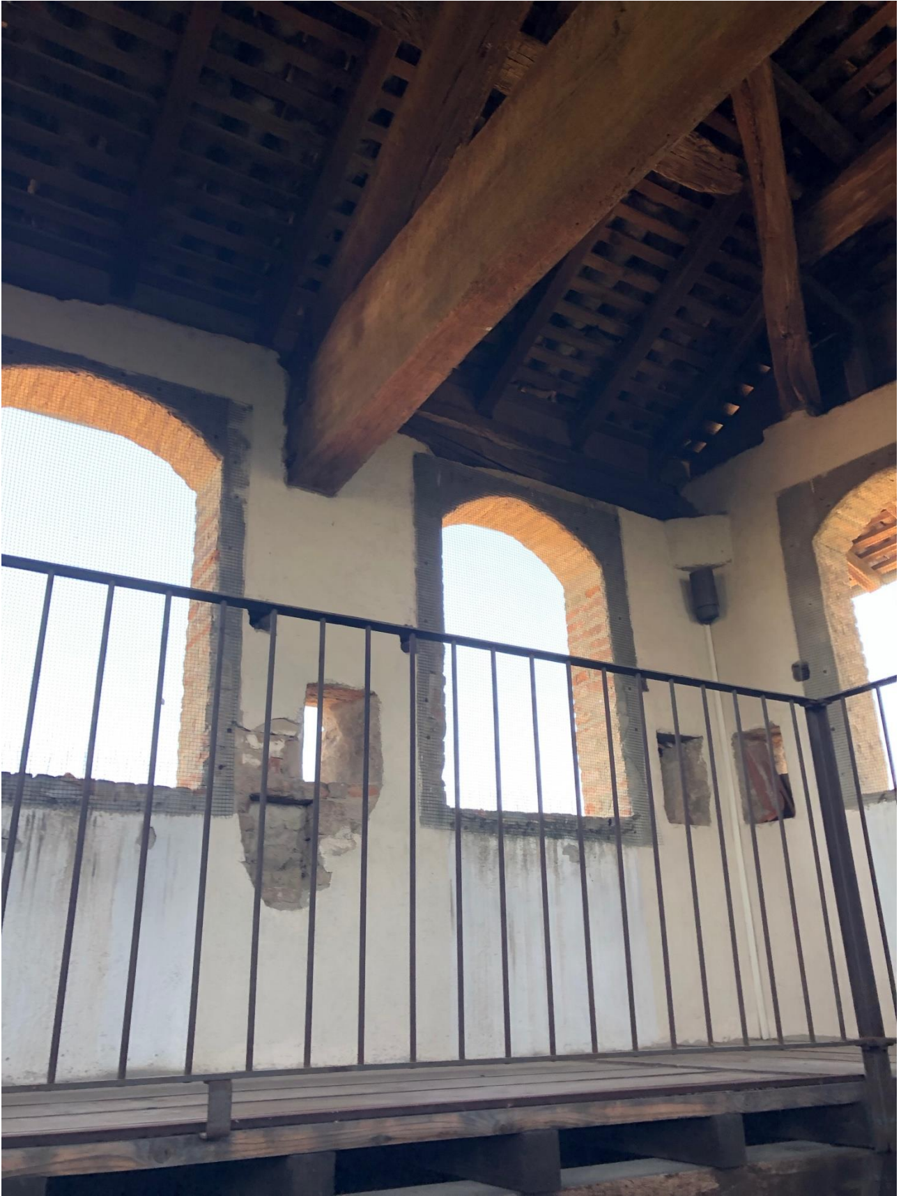
Foto 24 – Interno Torre di Guardia
