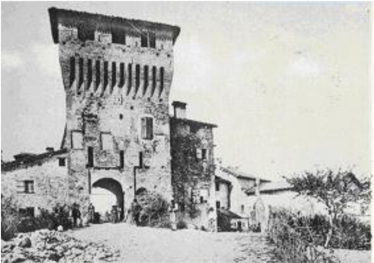
La Torre di Guardia in una fotografia del 1905
