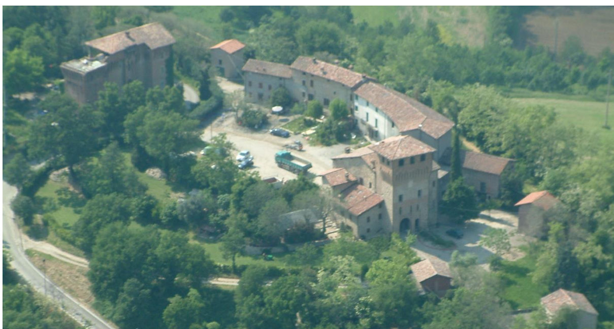
Veduta del complesso da nord-est
