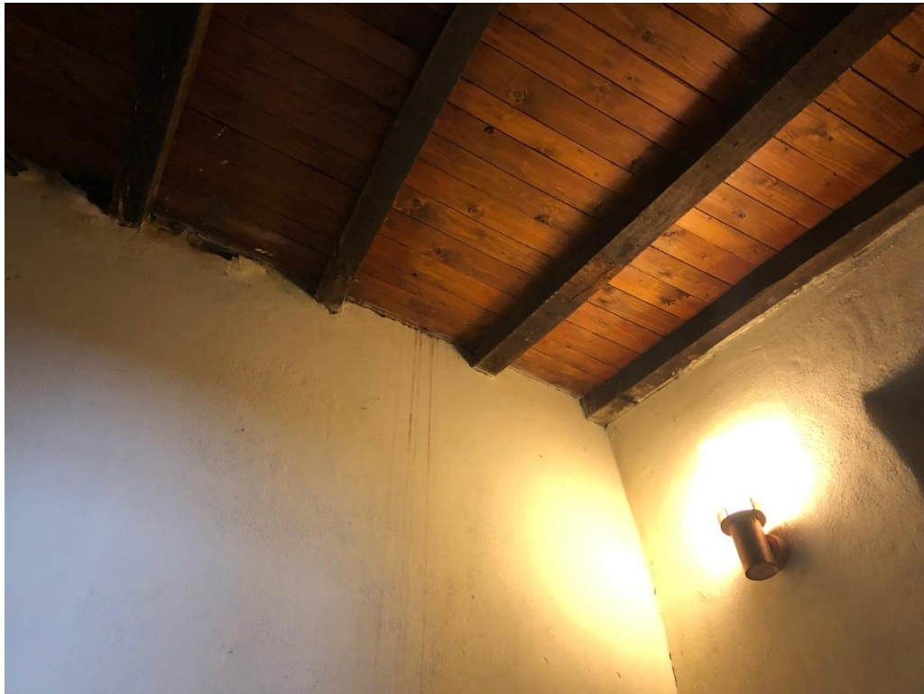
AMBITO 2 – interno vano scala – Piano Secondo
