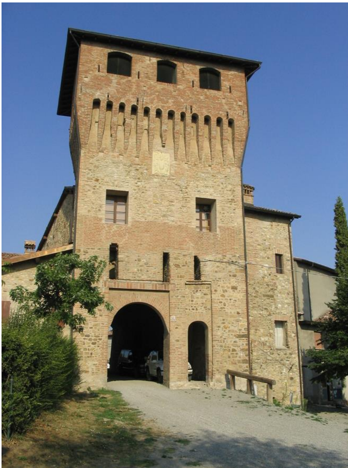
L'ingresso monumentale della Torre di Guardia dopo i restauri
