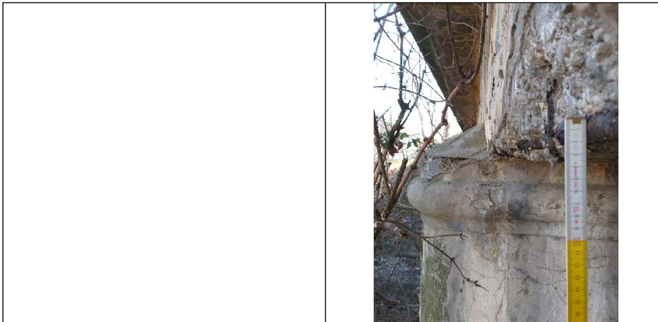
Fig. 3.3 – Vista degrado armatura della trave di bordo Corsia Ovest – Campata Scandiano
