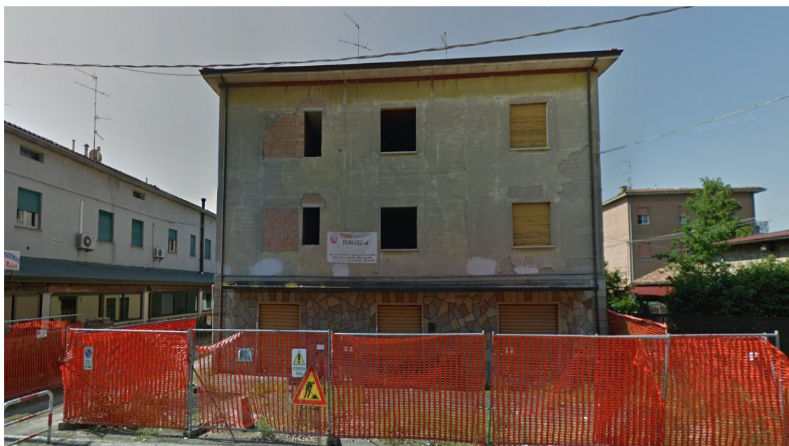
Prospetto Sud Edificio
