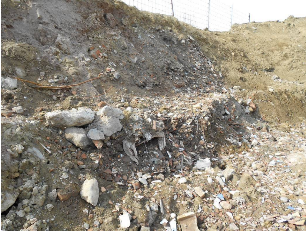
Fig. 2.4 – Parete dello scavo sul confine sud del sito
