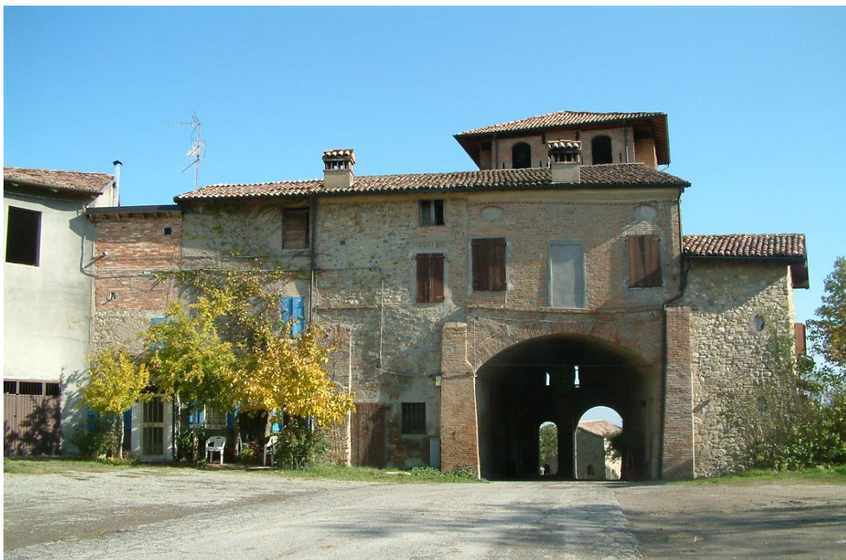
La parte interna della Torre di Guardia
