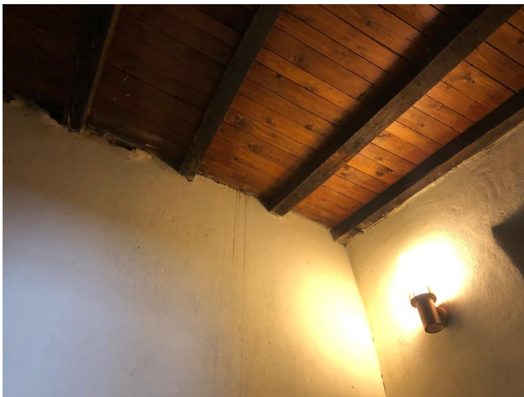
AMBITO 2 – interno vano scala – Piano Secondo
