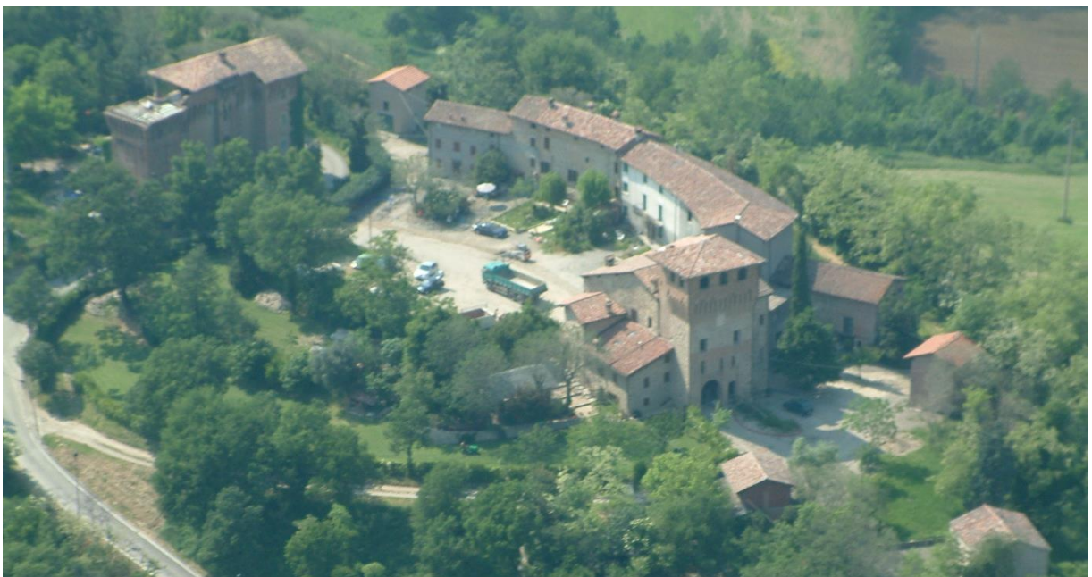
Veduta del complesso da nord-est
