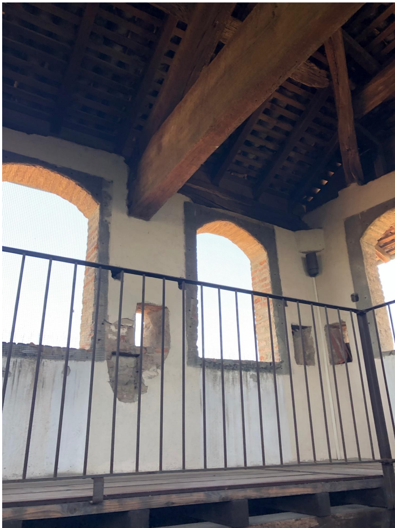
Foto 24 – Interno Torre di Guardia
