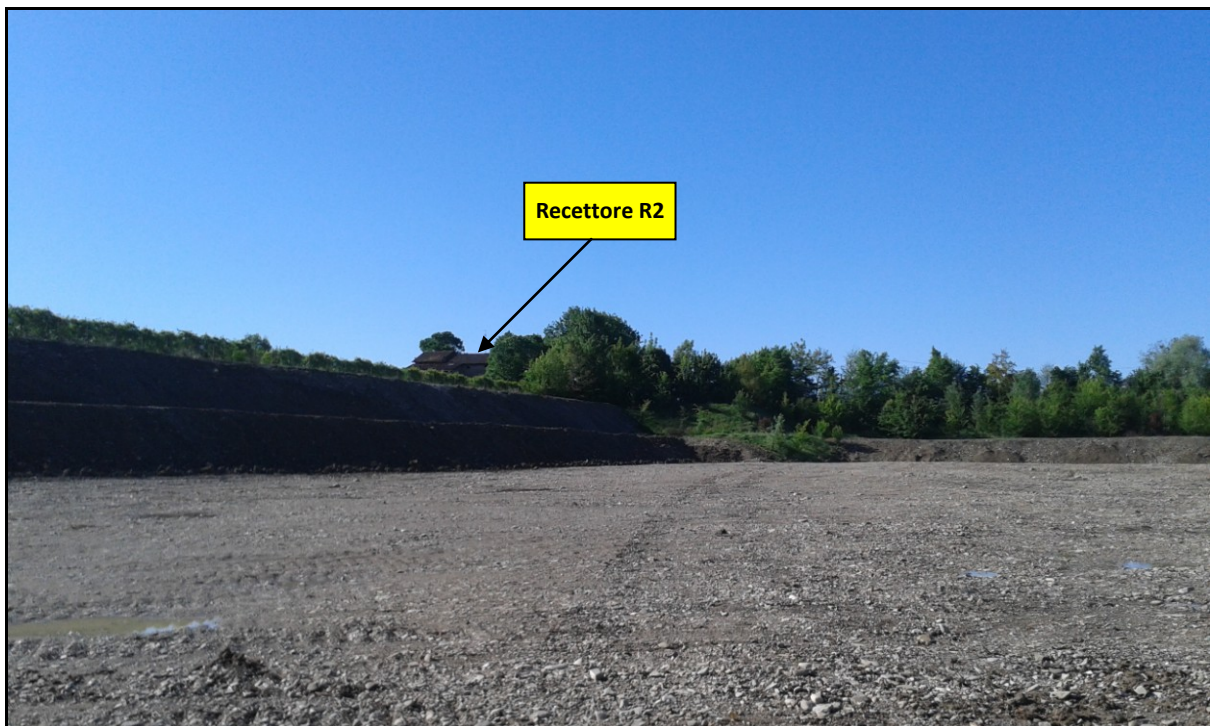
Figura 4: rilievi fotografici (vista recettore R2)
