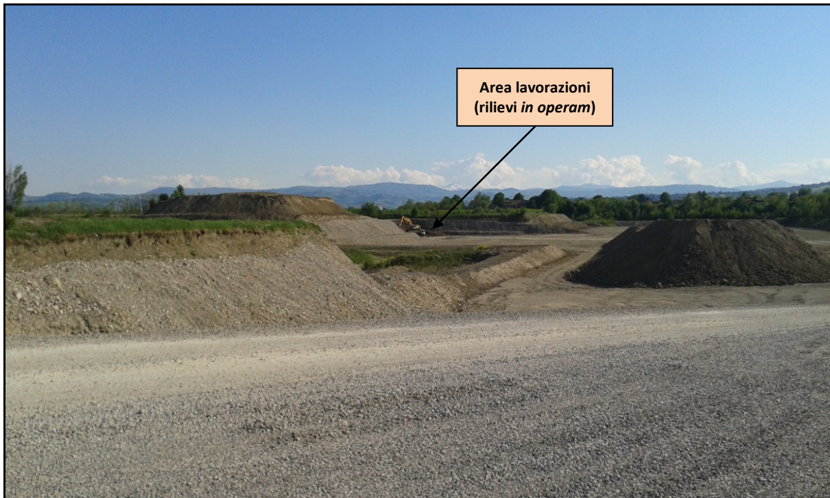
Figura 3: rilievi fotografici (vista attività in esame al momento dell'indagine)
