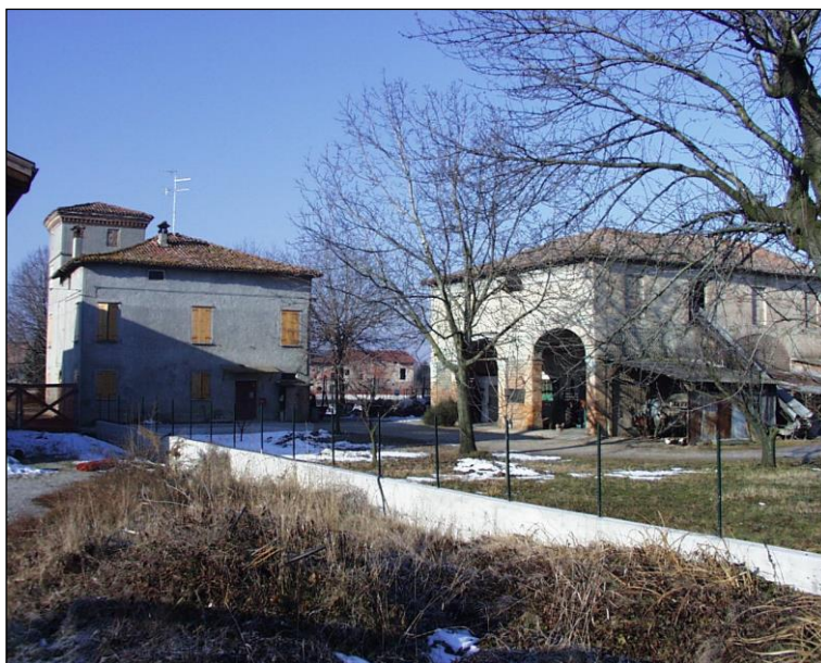
Foto 4 – Ripresa fotografica di Casa Colombaia.
