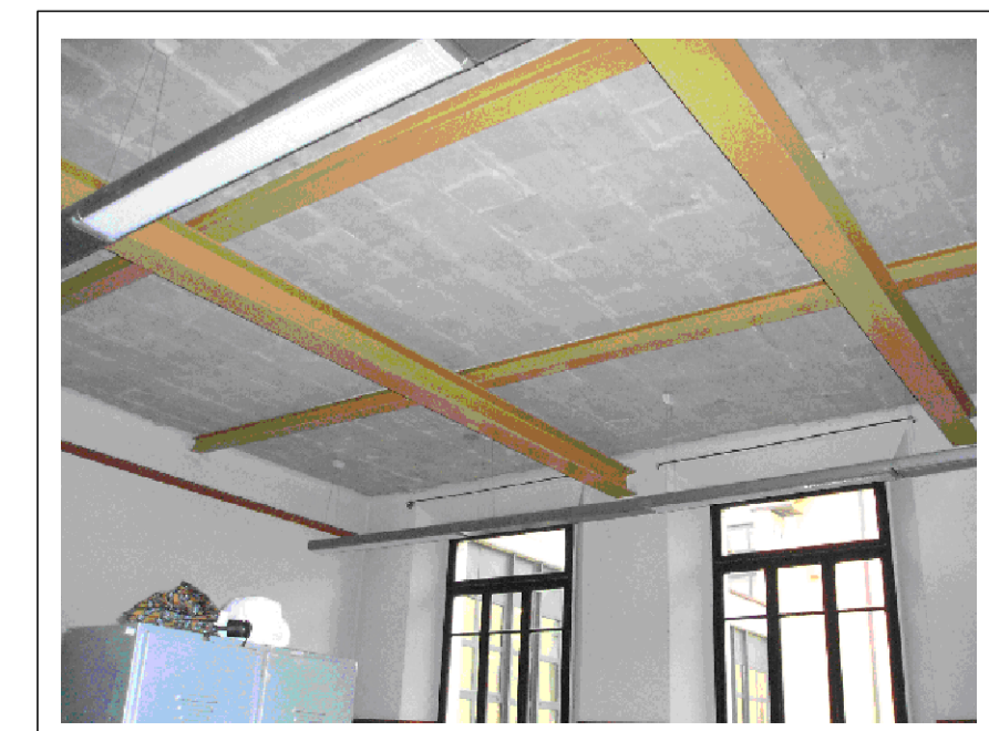
Particolare rinforzo solaio aula
