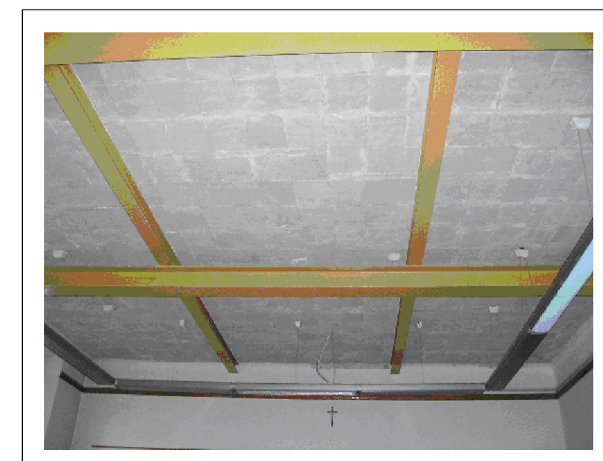
Particolare rinforzo solaio aula
