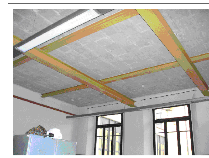
Particolare rinforzo solaio aula
