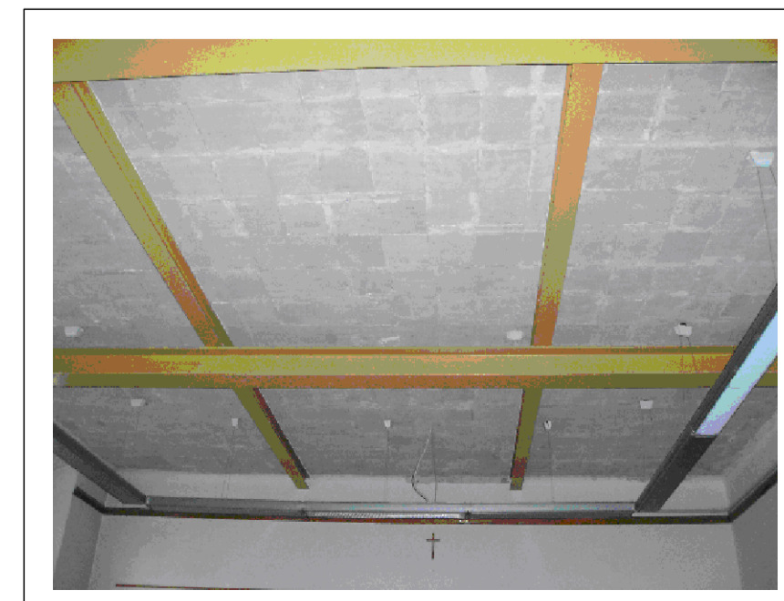
Particolare rinforzo solaio aula
