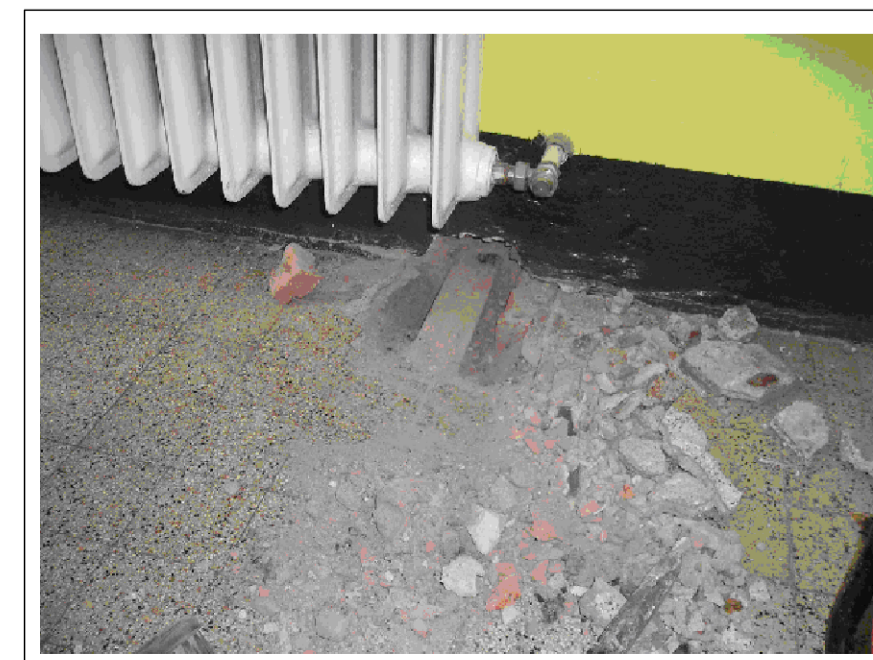
Particolare attacco solaio corridoio
