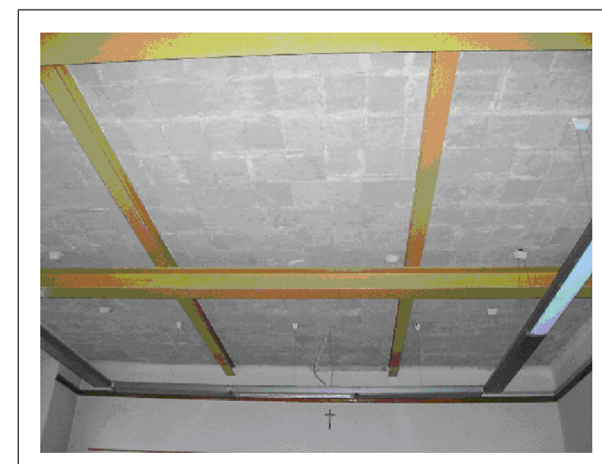
Particolare rinforzo solaio aula
