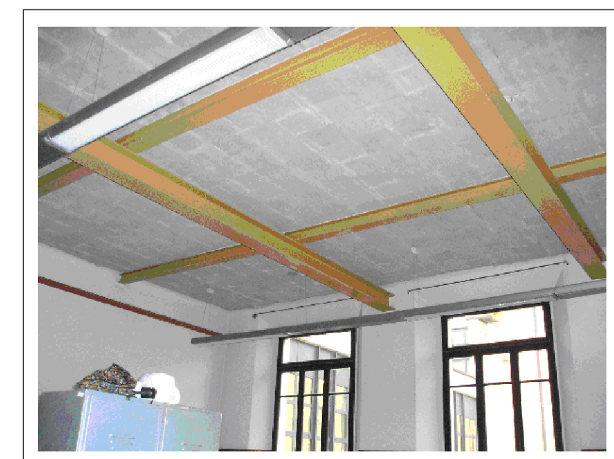
Particolare rinforzo solaio aula
